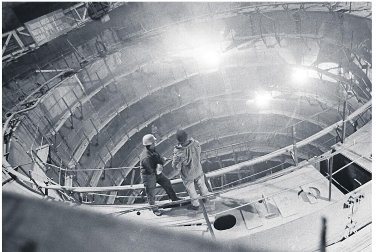
▲ Сварка конструкций атомного реактора первого блока, февраль 1973 года
