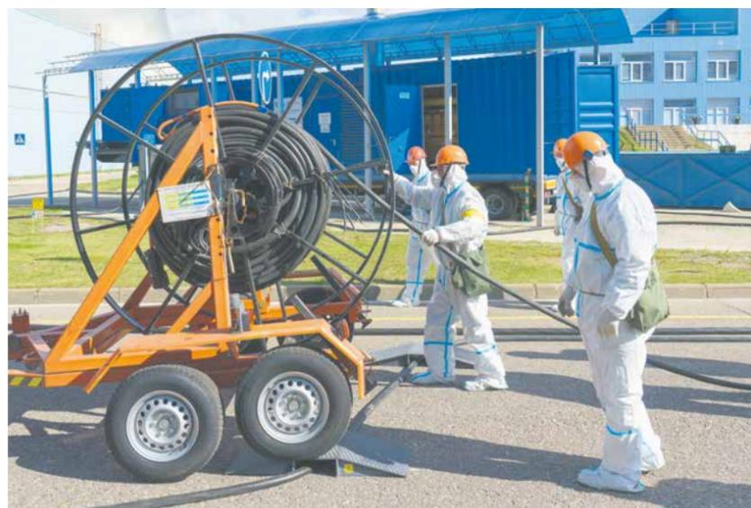
▲ За полтора часа вместо нормативных двух с половиной «обесточенный энергоблок» подключили к автономному источнику питания — передвижному дизель-генератору
