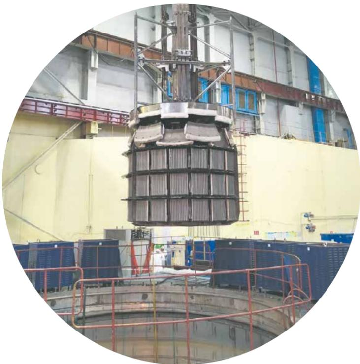
В 2020 году «Атомэнергоремонт» освоил новое направление — демонтаж и фрагментацию оборудования при выводе АЭС из эксплуатации. Первый участок по выводу из эксплуатации открылся на базе «Нововоронеж-атомэнергоремонта». Операции выполнялись на первом энергоблоке Нововоронежской АЭС и включали демонтаж, фрагментацию и дезактивацию парогенераторов и главных циркуляционных насосов.
