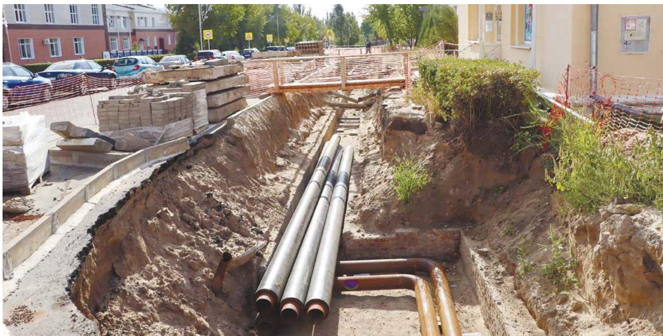
■ Обновленные магистрали будут стабильно обеспечивать теплом горожан в ближайшие 25–30 лет
