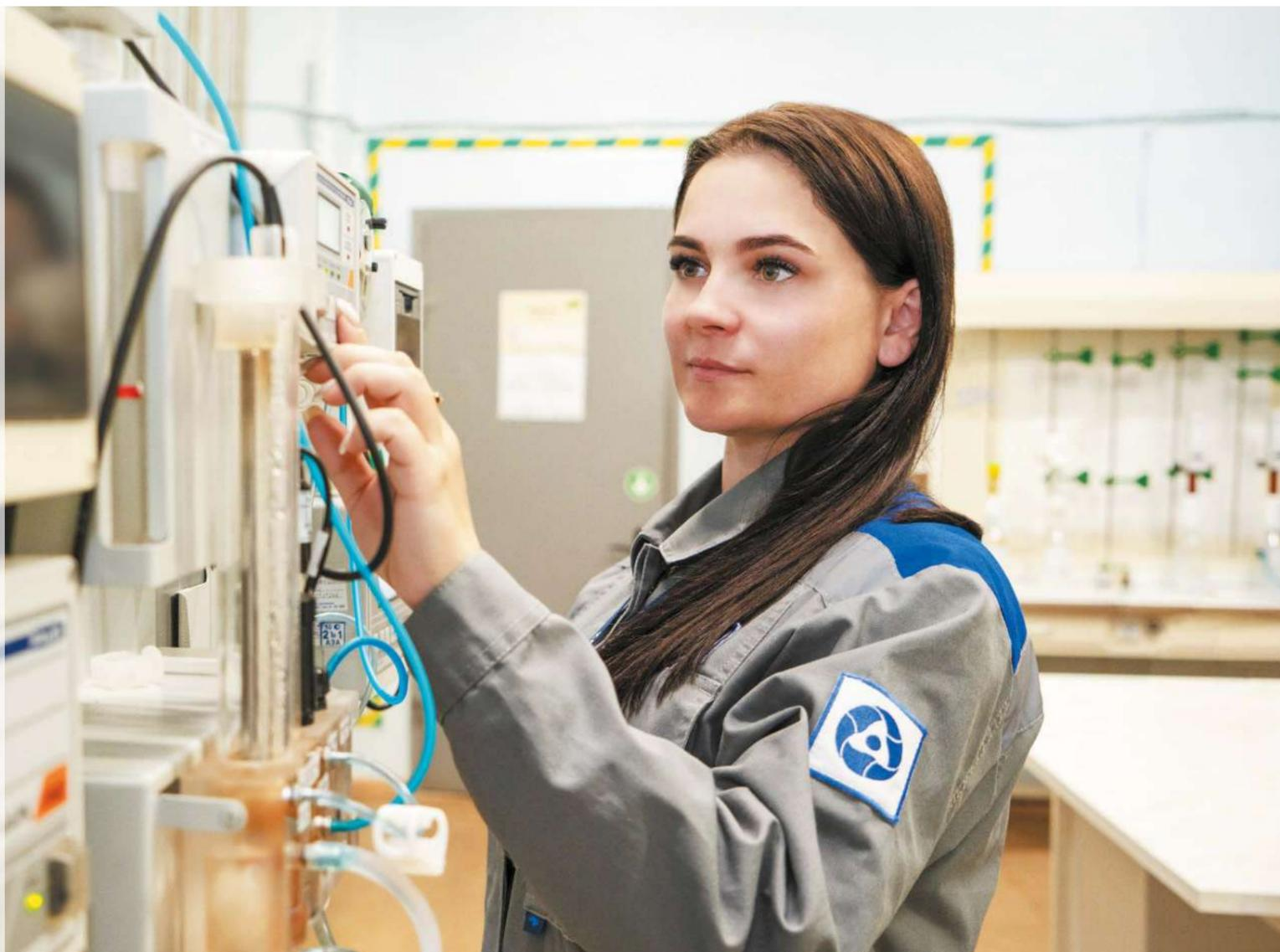
Дарья Ефимова, аппаратчик химводоочистки электростанции ХЦ КЛНАЭС, ведет контроль технологического процесса обессоливания воды и регулирование параметров процесса по показаниям средств измерений, результатам химических анализов, сигнализации на местных щитах управления
