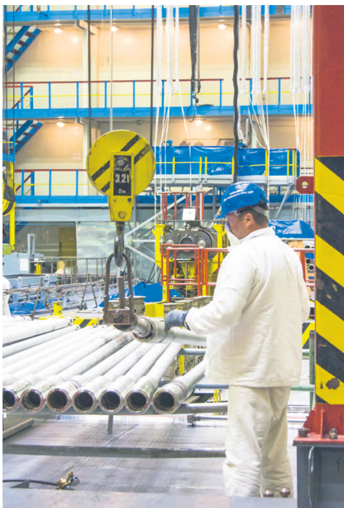
▲ Осмотр обойм пароводяных коммуникаций в центральном зале первого энергоблока Смоленской АЭС
