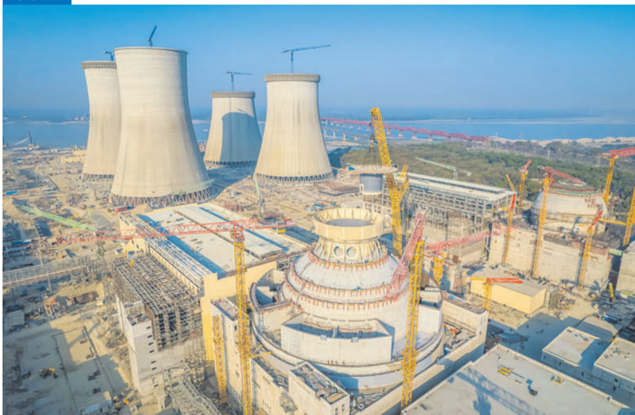
▲ Бангладеш, АЭС «Руппур». На первом блоке с реактором ВВЭР-1200 установили дефлектор системы пассивного отвода тепла — на 45 дней быстрее запланированного
