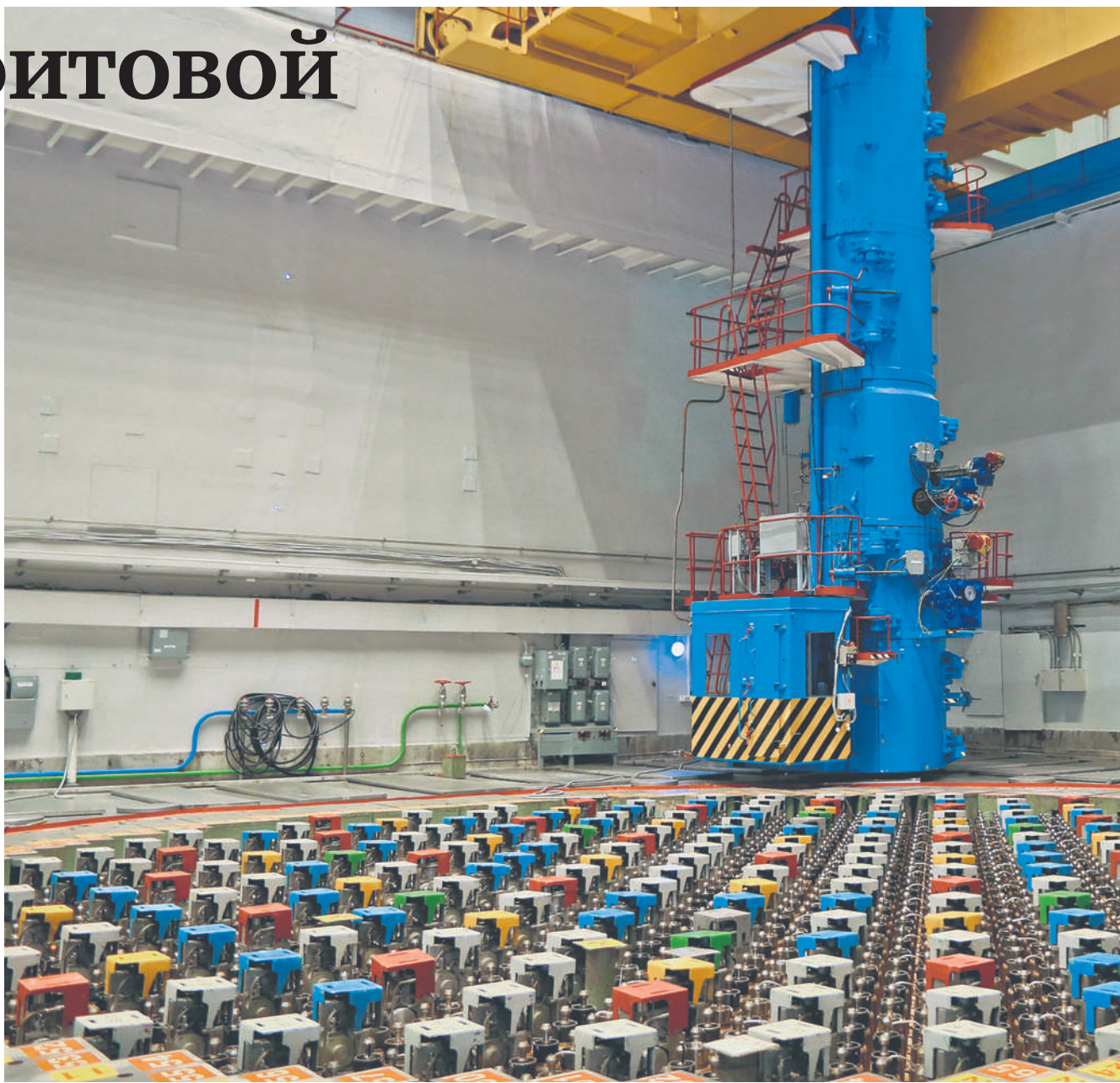
▲ Плато реактора первого энергоблока Смоленской АЭС перед ремонтом
