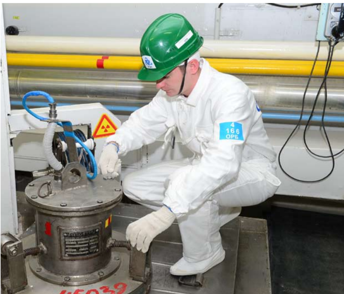
Дмитрий Фадеев, будучи дозиметристом, осматривает оборудование химцеха перед проведением измерений
